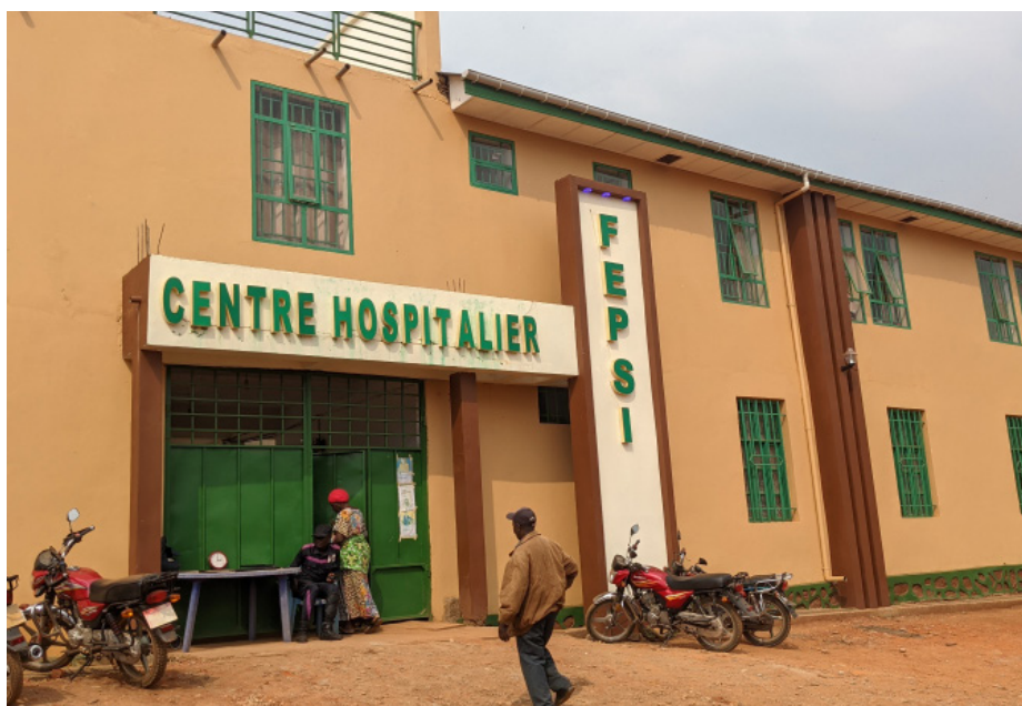
Bâtiment du Centre Hospitalier FEPSI à Butembo. Ph Jérémie Kyzsekera
